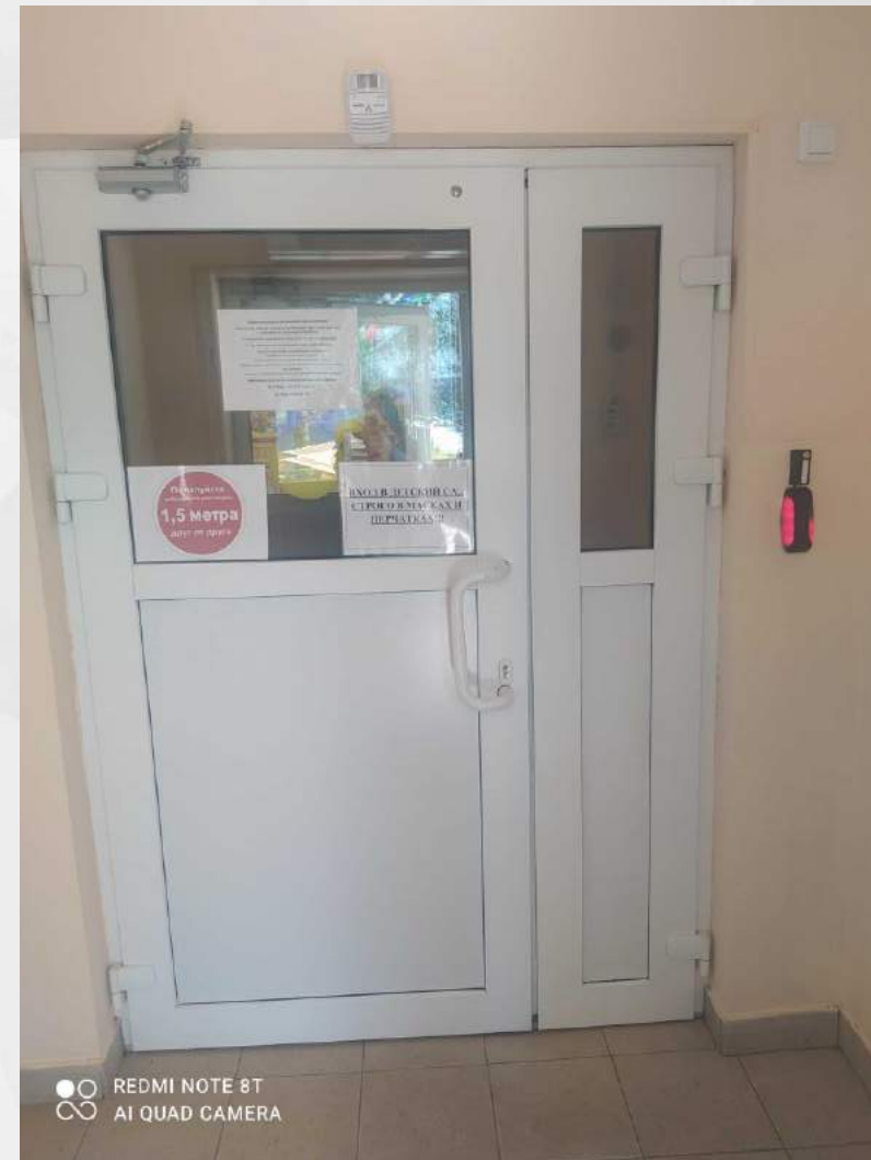
Входная дверь центральная
